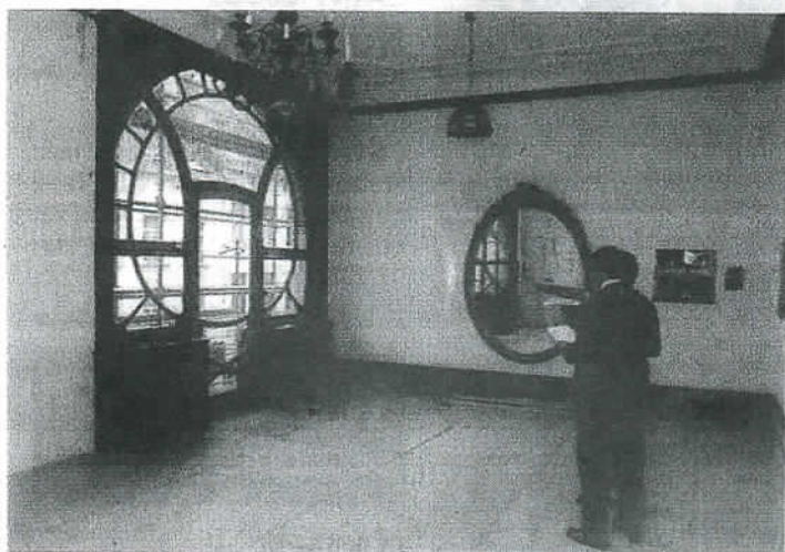
Le salon de l'hôtel Ciamberlani, en pleine rénovation. ■ LLANGE
